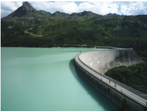
Pumpspeicherkraftwerk Kopswerk in Vorarlberg
